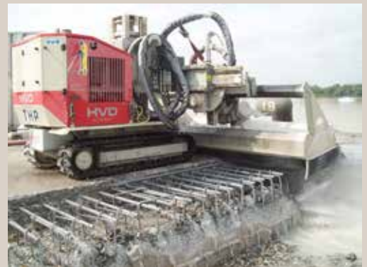
Hydrodémolition au robot.
