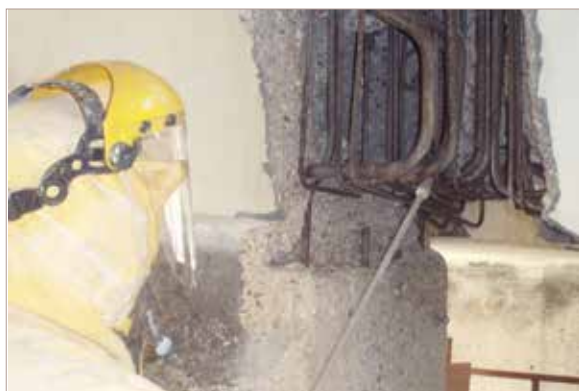
Hydrodémolition à la lance sur les corbeaux d'un ouvrage d'art.
