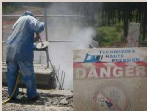
Hydrodémolition à la lance.
