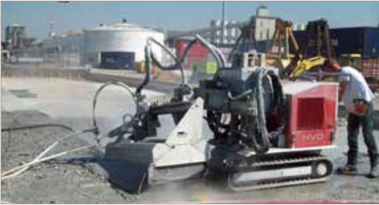
Travaux d'hydrodémolition au robot de la dalle du quai sur le port de Bassens.
