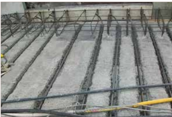
Afin de renforcer le tablier du viaduc du Courtineau, des saignées ont été pratiquées pour y rajouter des barres.
