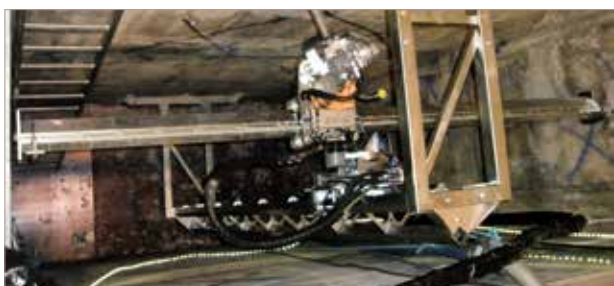
Hydrodémolition robotisée en plafond.
