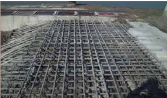
Résultat obtenu après l'hydrodémolition au robot de la dalle.
